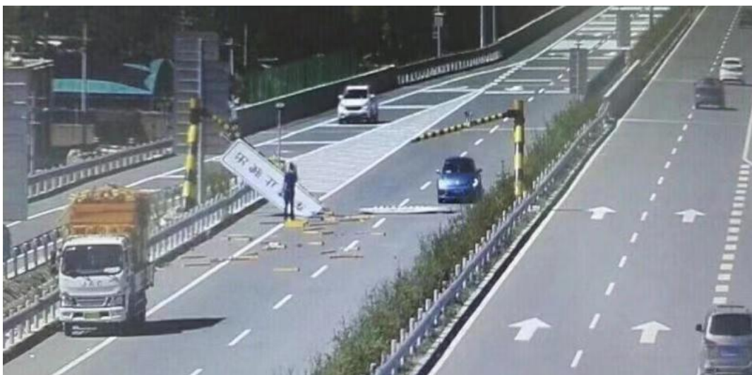
8月11日,同仁北通往牙什尕方向,一辆中型货车因载货超高将限高架撞断,高管局工作人员随即到达现场处理事故。事后工作人员对这位司机进行了批评教育,在有明显标识的高速公路上任何人都不能存在侥幸心理,否则害人害己。司机向工作人员道歉后对损坏的限高架进行了照价赔偿。李燃 摄
